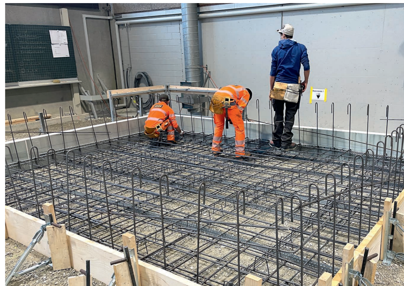
Lernende bei der Arbeit an einer Bodenplatte.
